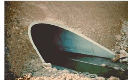
La Haye du Puits – Ouvrage hydraulique
