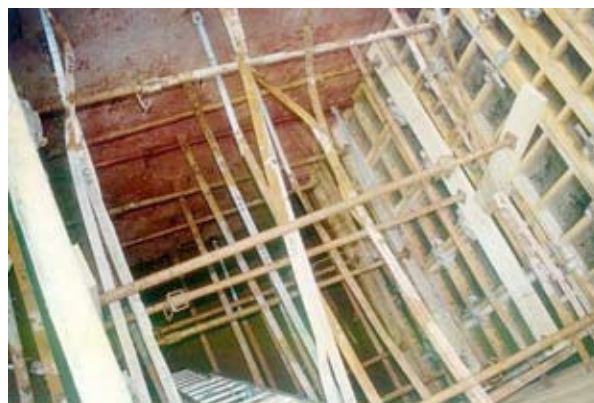
Photo 4 : vue de dessus d'une grande fouille – Source : Lr de Strasbourg
