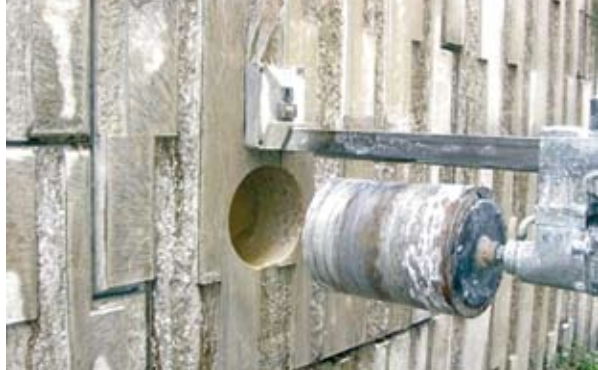
Photo 5 : réalisation du carottage en parement du mur Source : Jean-Marc Jailloux
